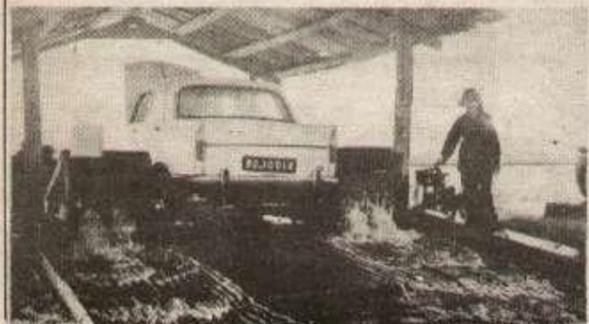
Une voiture est utilisée pour faire fonctionner quatre pompes en même temps, ce qui permet de réaliser une importante économie d'essence, tandis que les roues sont utilisées pour les charrettes.
