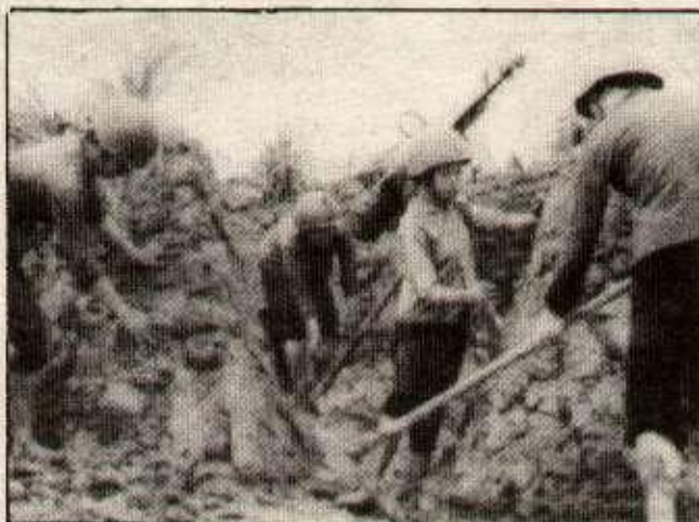
Consolidation des talus et tranchées de défense anti-aériens.
