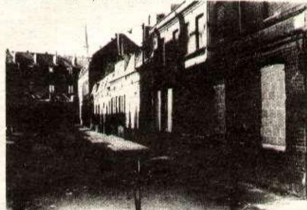
Une cour dans le quartier de Alma-gare. A mesure que les habitants s'en vont, la municipalité s'empresse de murer portes et fenêtres...
