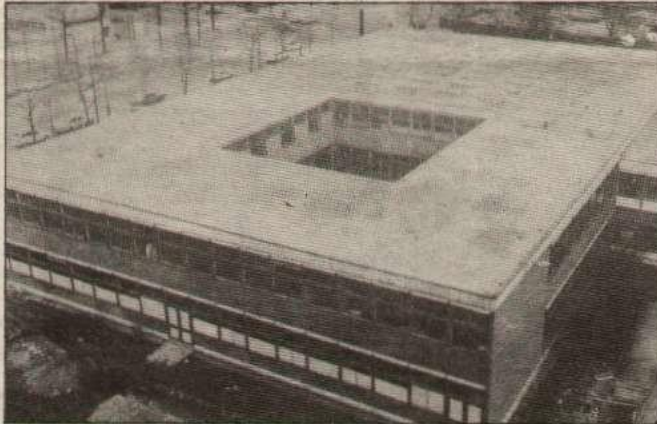
Le CES Vincent d'Indy à Paris : construit sur le même type que le CES Pailleron, il a fait la rentrée 1977.
