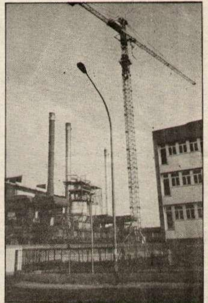
Issy-les-Moulineaux : l'usine de la TIRU (incinération d'ordures).
