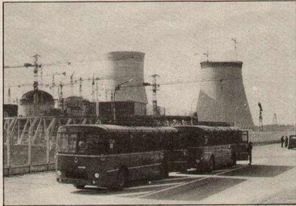
▲ L'entrée du chantier est bloquée par plusieurs cars de gardes mobiles.
