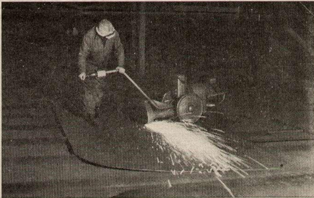
Le travail de finition sur des pièces en tôle (ici dans la sidérurgie du Nord) : cisailage, meulage, etc...
