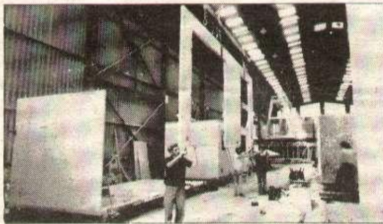
Le plâtre : de bonnes affaires pour Lafarge... sur le dos des travailleurs.
