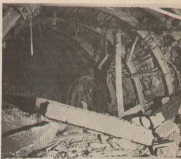
Mur écroulé. Il devait empêcher la sortie du grisou.
