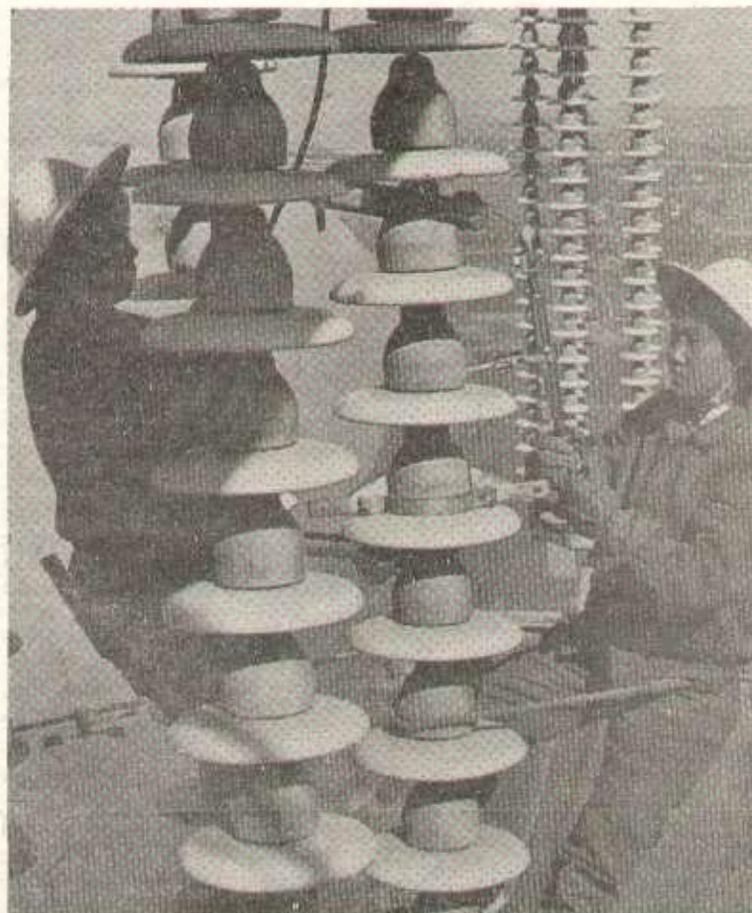
Sur notre photo deux ouvrières électriciennes de Wouhan réparent une ligne sous tension. Au premier plan des isolateurs thermiques ; leur fabrication très délicate a été assurée par les ouvriers de l'usine dont il est question dans notre article.
