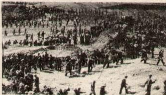
Des paysans travaillent sur un chantier de construction hydraulique.
