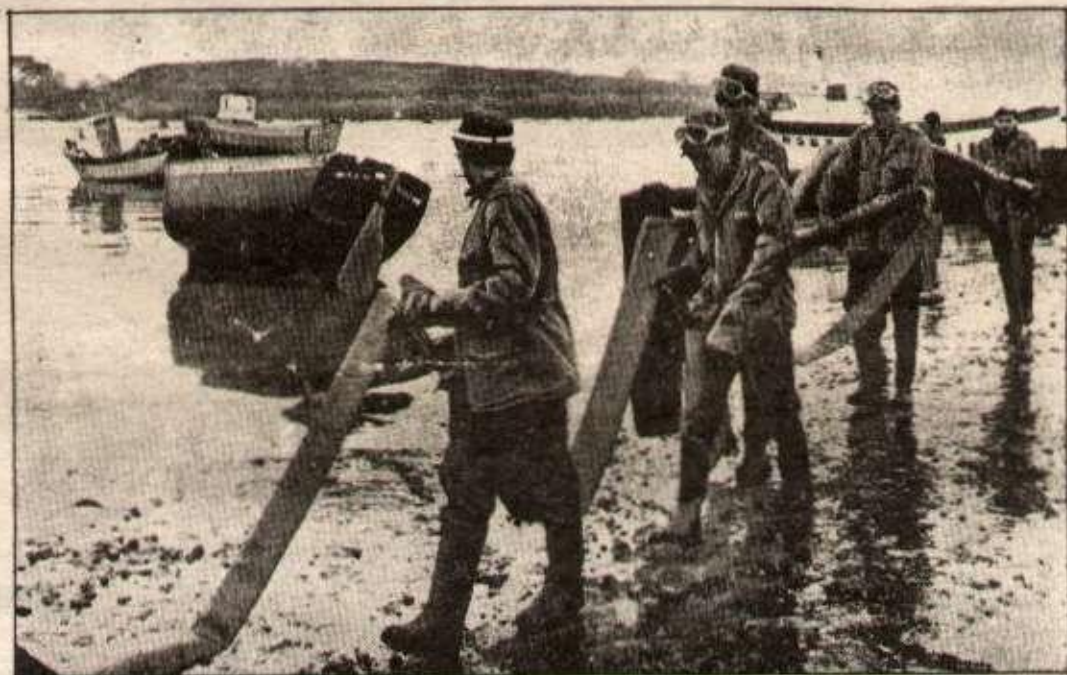
Des moyens dérisoires pour pomper des milliers de tonnes de pétrole.
