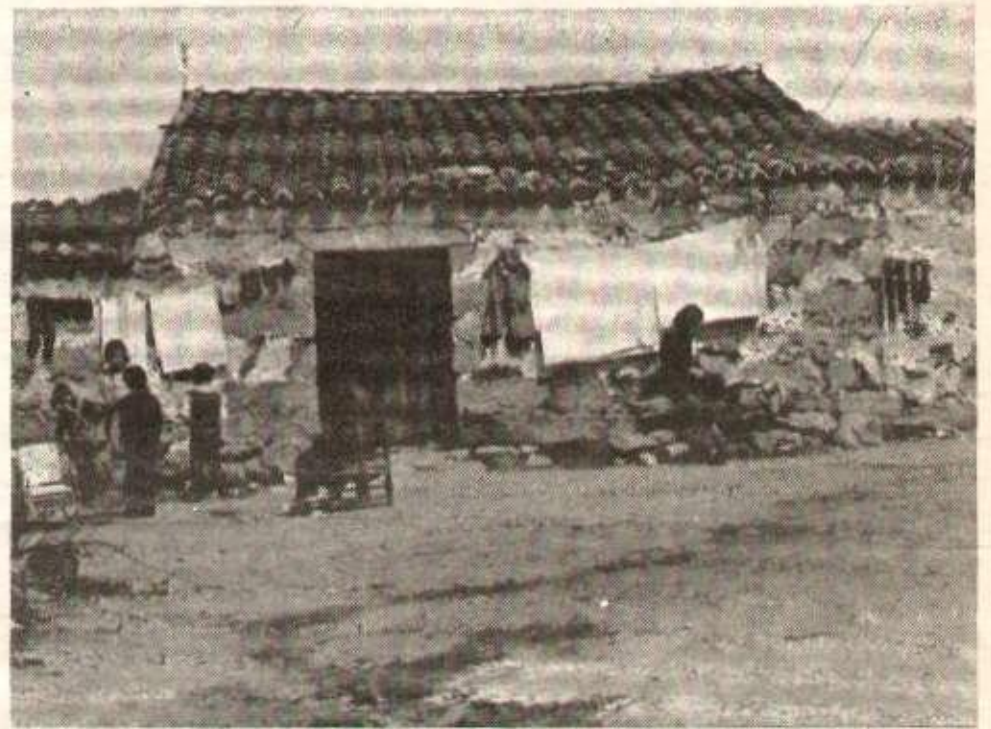
A la campagne comme à la ville, le problème du logement et du manque d'équipements sociaux et sanitaires est crucial.
